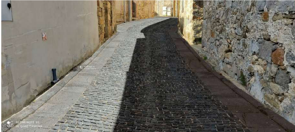
Via Vittorio Emanuele dopo dell'intervento
