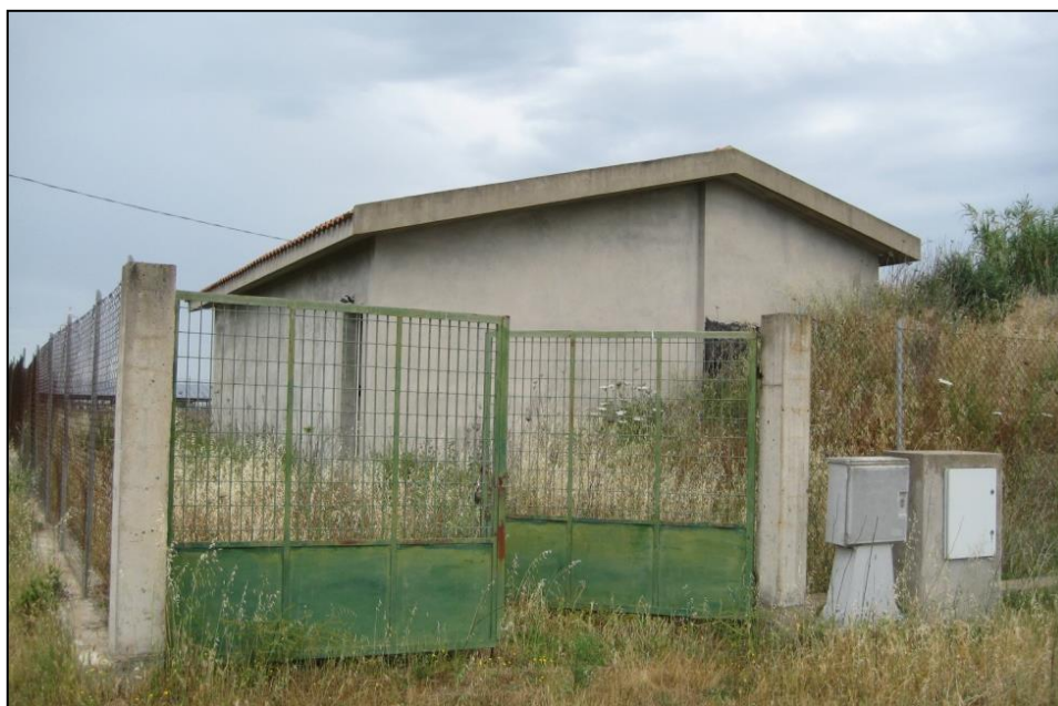
Figura 6: Serbatoio acqua grezza.
