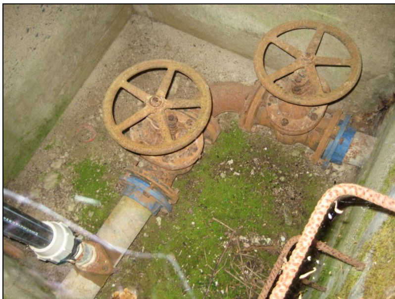
Figura 11: Particolare pozzetto di manovra.
