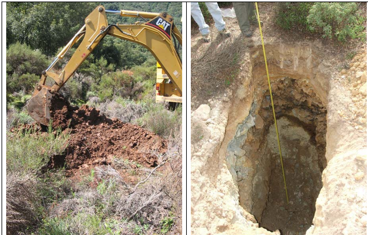
Figura 2.6. – Pozzetti di prelievo dei campioni eseguiti con mezzo meccanico
