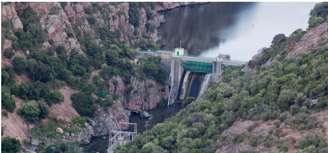
Figura 5. Diga di Casteldoria
