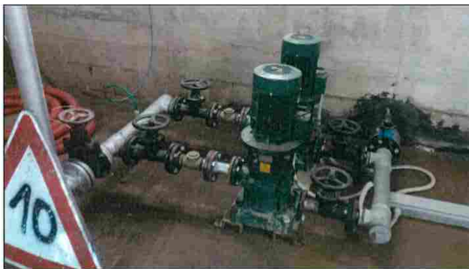
Figura 7: Particolare modulo di sollevamento idrico potabile.
