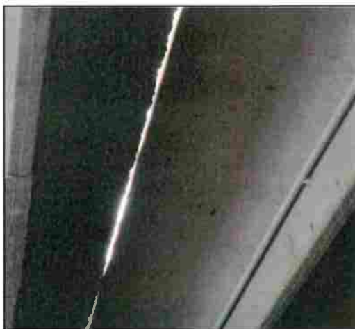
Figura 11: Particolare fessure solaio serbatoio.
