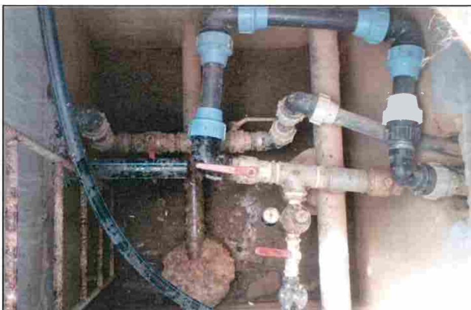
Figura 16: Particolare pozzetto di allaccio.
