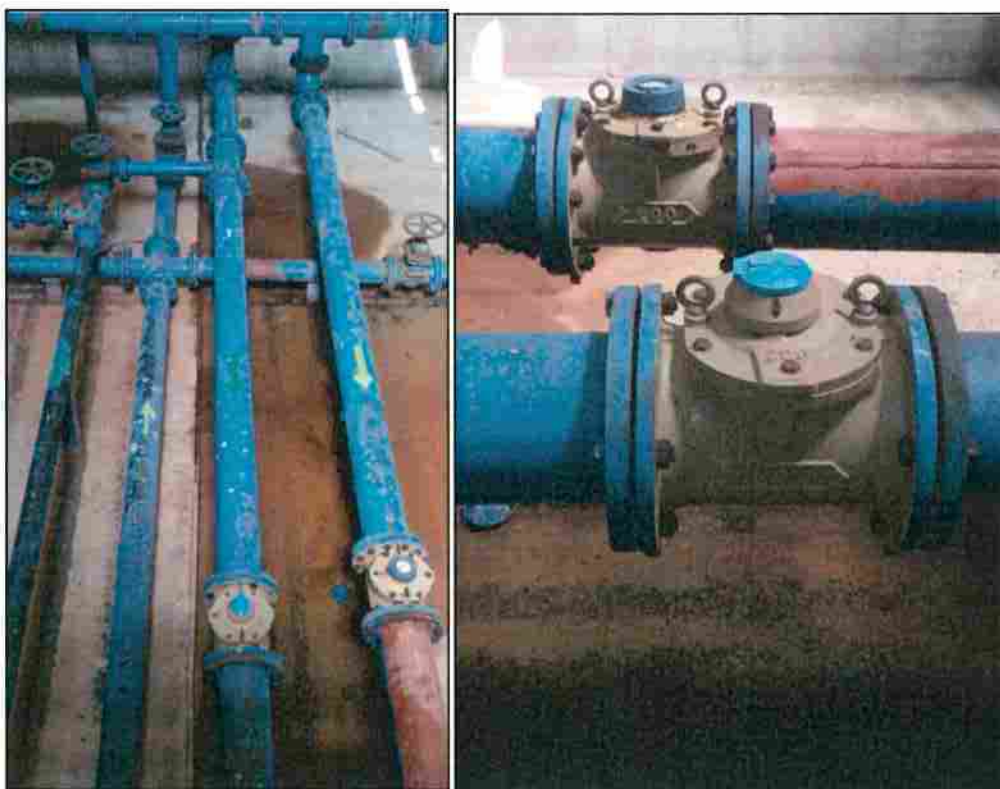
Figura 13: Particolari alimentazione duale serbatoio.
