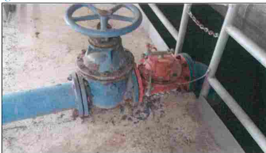
Figura 14: Particolare valvola regolatrice di livello.
